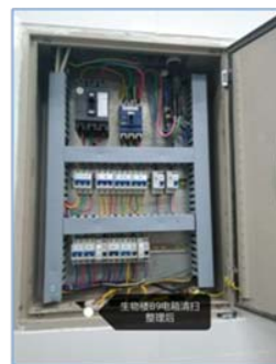
生物楼B09房间配电箱 线路整理（整改后）
