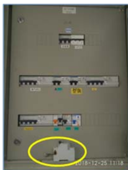
能源1号楼206房间配电箱 更换烧糊开关（整改后）
