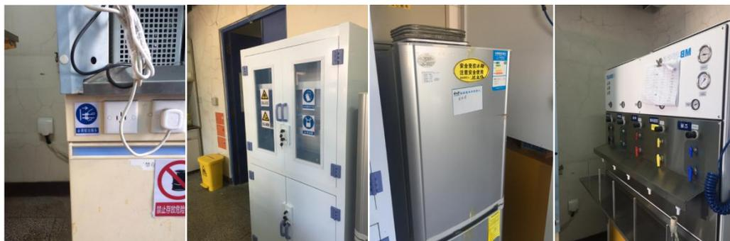
催化楼 408 实验室设房间排风机 1 台、通风柜四台，有害气体、蒸汽、气味、挥发物质等实验工作在通风柜内进行。
